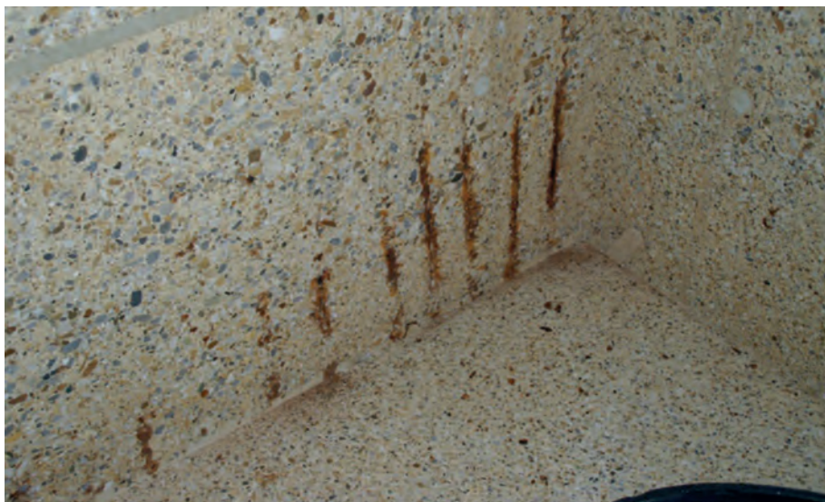
Abb. 3: Lösender Betonangriff
