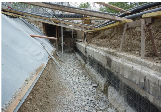
Bild 11. Instandsetzungsöffnungen Schlitzwand Ost
