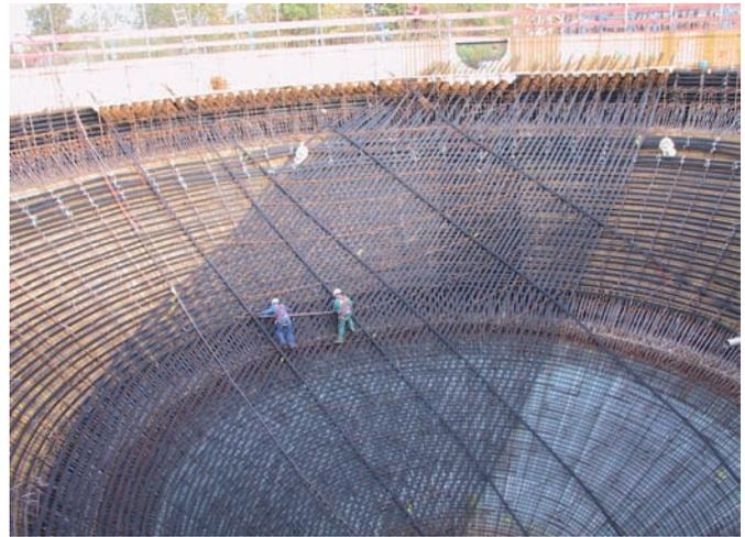
**Bild 10. Hyperbolische Vorspannung**
