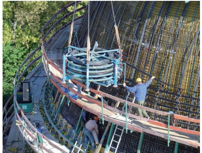
**Bild 8. Horizontale Vorspannung**
