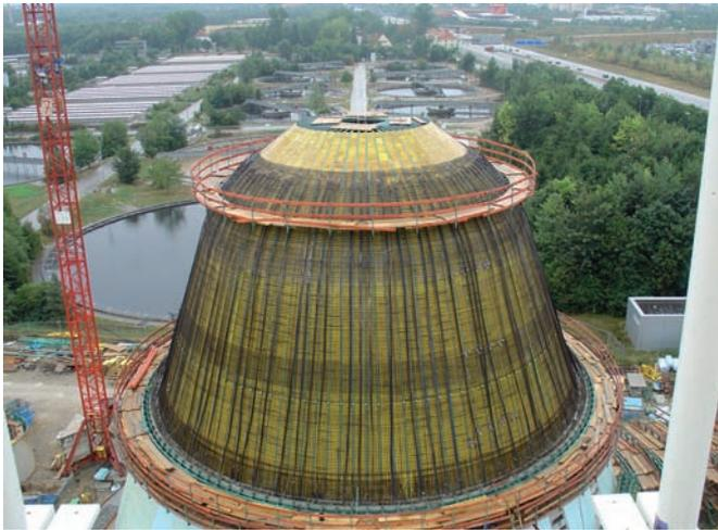
**Bild 9. Vertikale Vorspannung**
