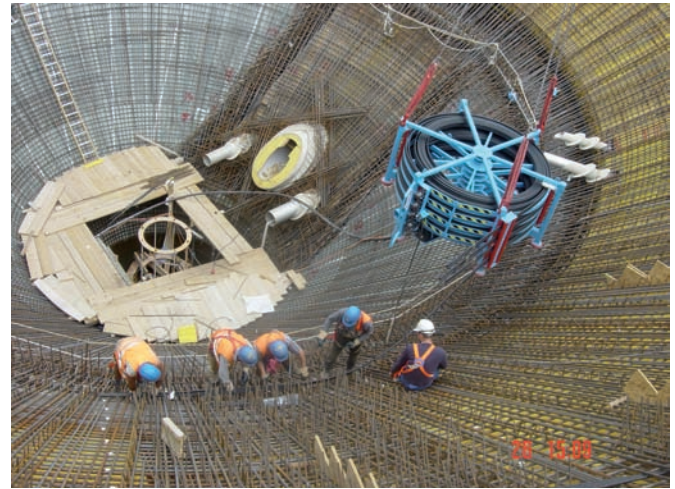
Bild 6. Verlegen der horizontalen Spannglieder mit Hilfe des Abrollers Fig. 6. Laying the cables of horizontal prestressing by using the unwinder
