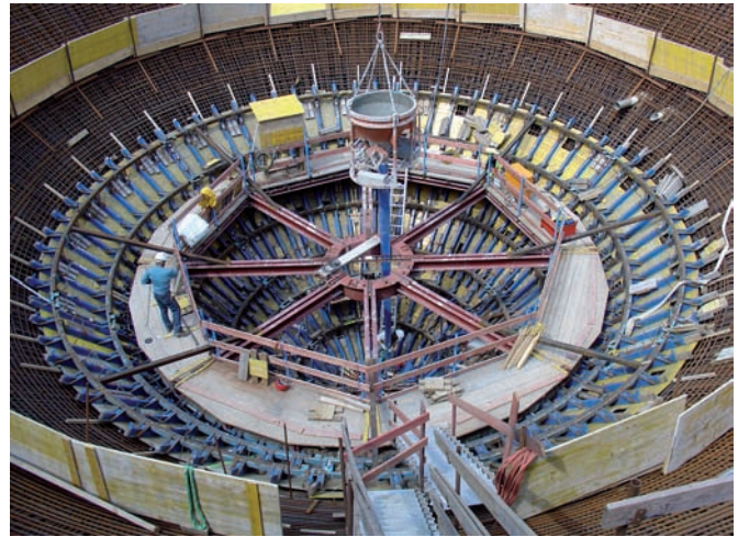
Bild 7. Betonage des ersten Bauabschnittes
