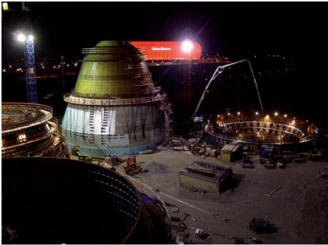
Bild 5. Betonierarbeiten im Schichtbetrieb (Foto: P.-M. Hübner) Fig. 5. Placing the concrete in shift operation
