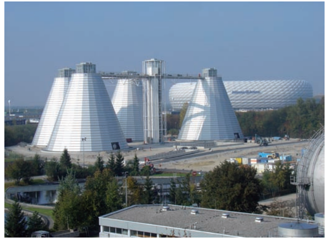
Bild 8. Faulbehälteranlage im Oktober 2007 (Foto: P.-M. Hübner) Fig. 8. digester facility in october 2007
