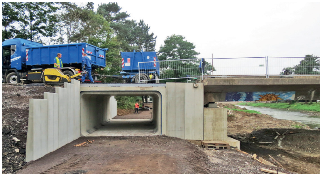
14 Fußgängerquerung nach Fertigstellung © Becker Ingenieure GmbH
