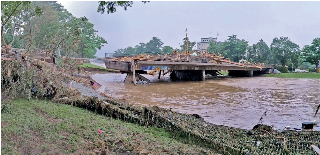
4 Verklaustrer Durchflussquerschnitt mit Umspülung des südlichen Widerlagers © Becker Ingenieure GmbH
