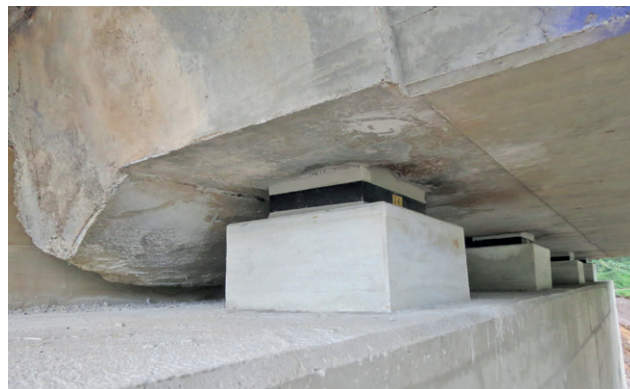
13 Überbaulagerung auf neuem Widerlager © Becker Ingenieure GmbH
