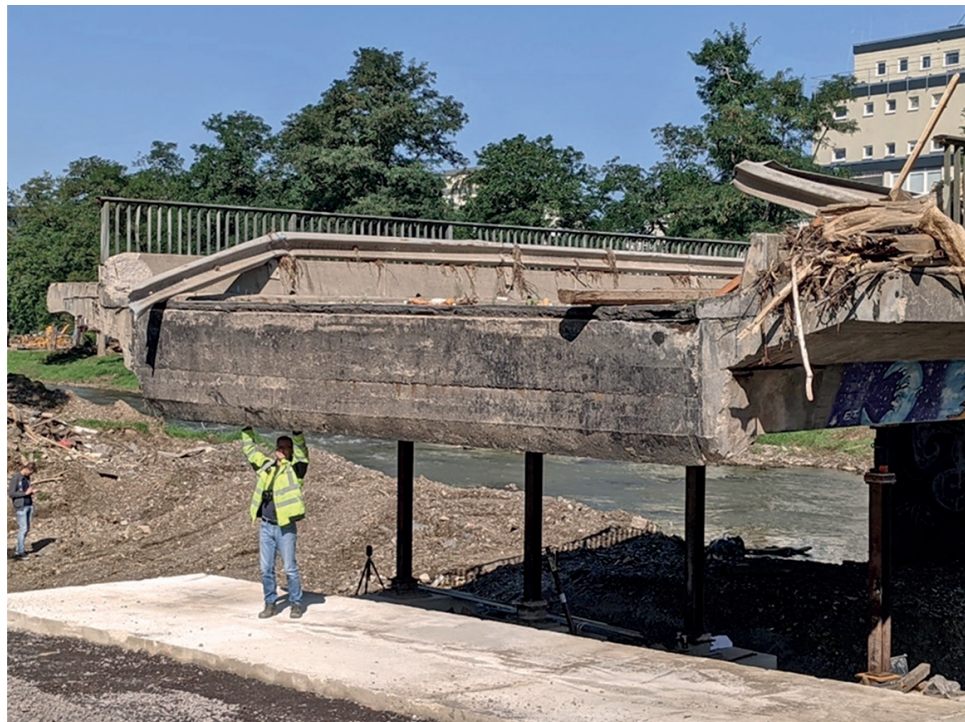
12 Bauwerkszustand nach dem Anheben © Becker Ingenieure GmbH
